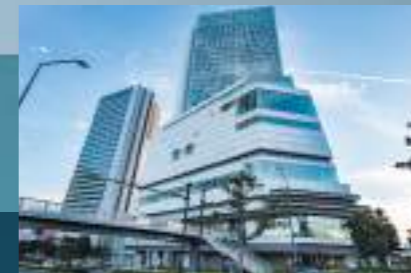
2 ラクシス フロント(横浜市庁舎内商業施設) (約2,400m)
